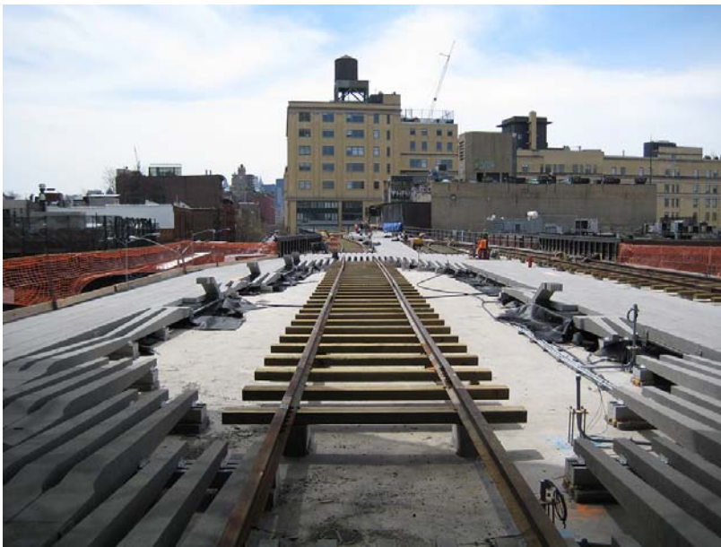
Construction de la High Line
