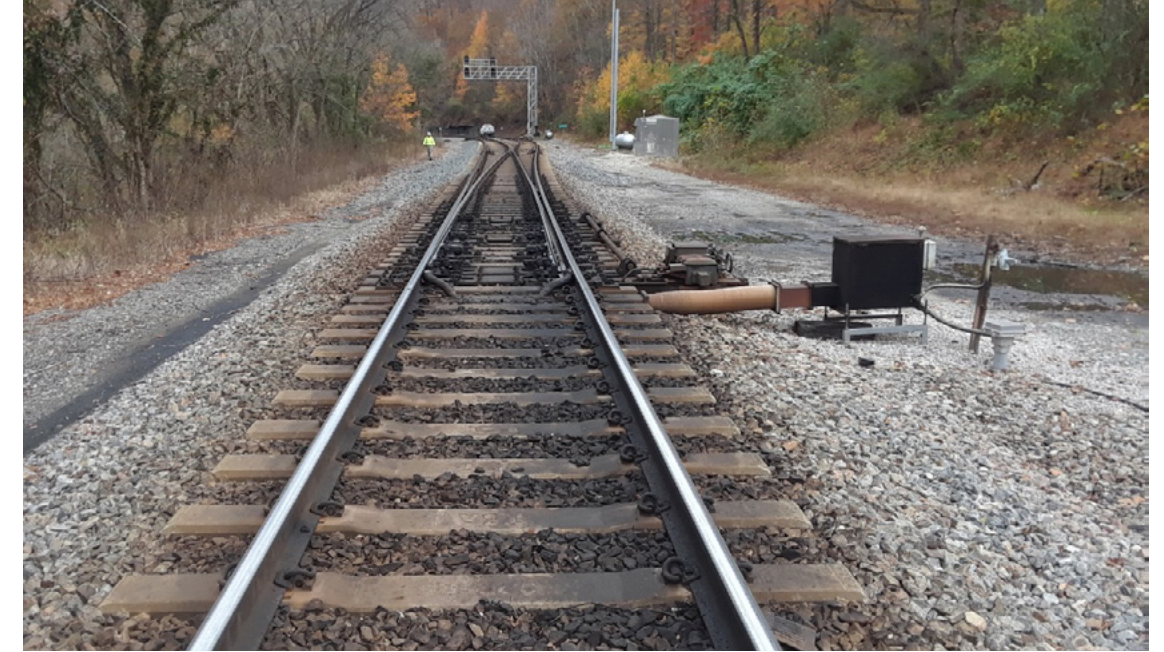
Figure 2 Travaux de rénovation d'un aiguillage avec sous-couche en enrobé bitumineux
