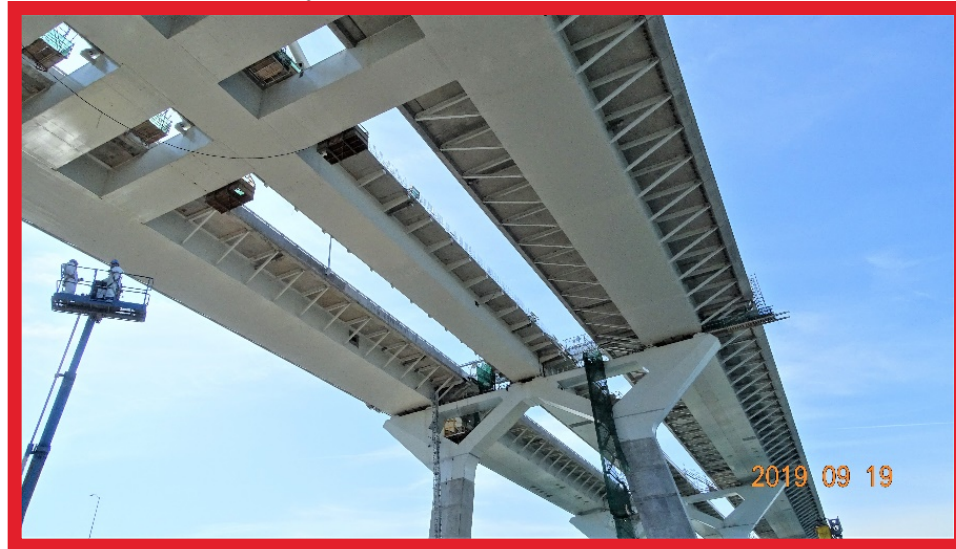
Ossature – Travées d'approches
