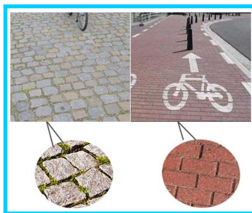
Figure 51 : Ancien pavé en pierre, rugueux et irrégulier (à gauche) comparativement au pavé moderne relativement lisse et nivelé (à droite)
