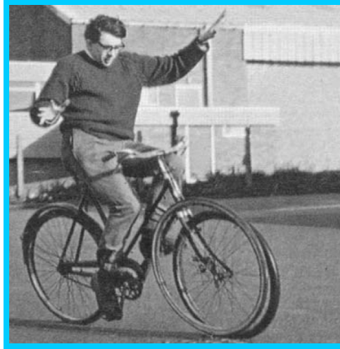
Figure 11 : Vélo expérimental de David E. Jones sans effet gyroscopique (Réf.: 9)
