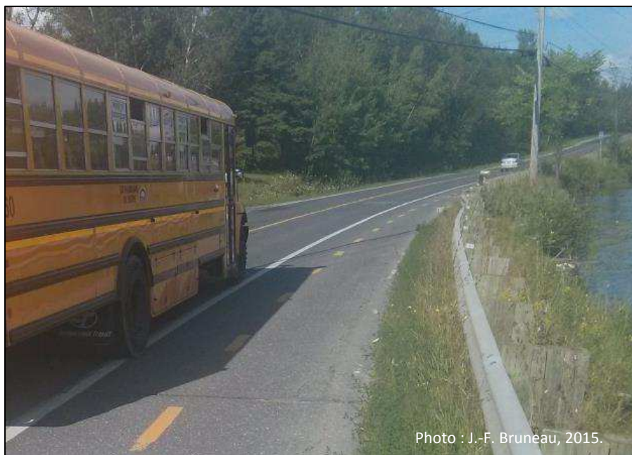
Figure 126 Bande bidirectionnelle non protégée sur route à haute vitesse
