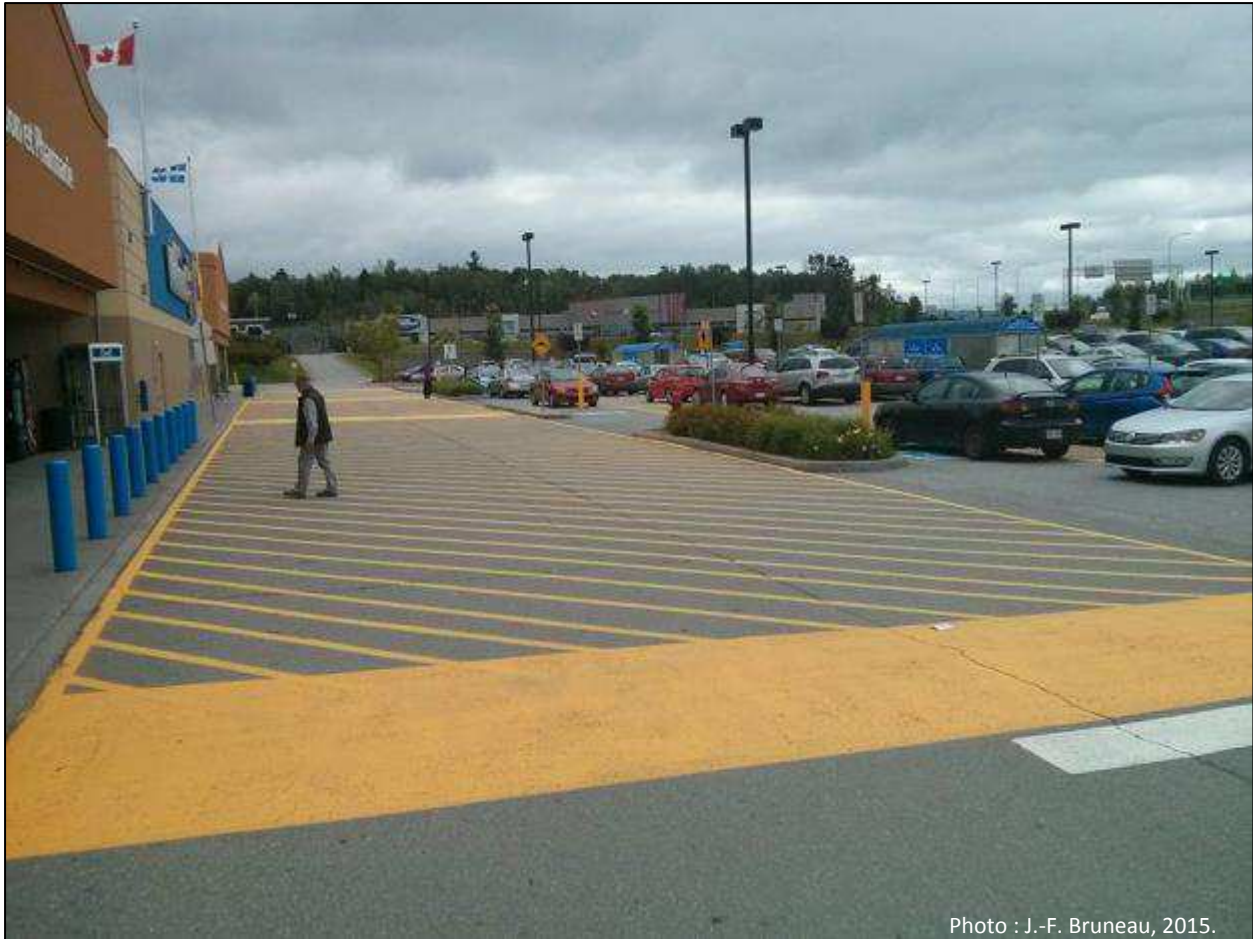
Figure 87 Zone de passage avec arrêt, marquage jaune et dos d'âne (Sherbrooke, Québec)
