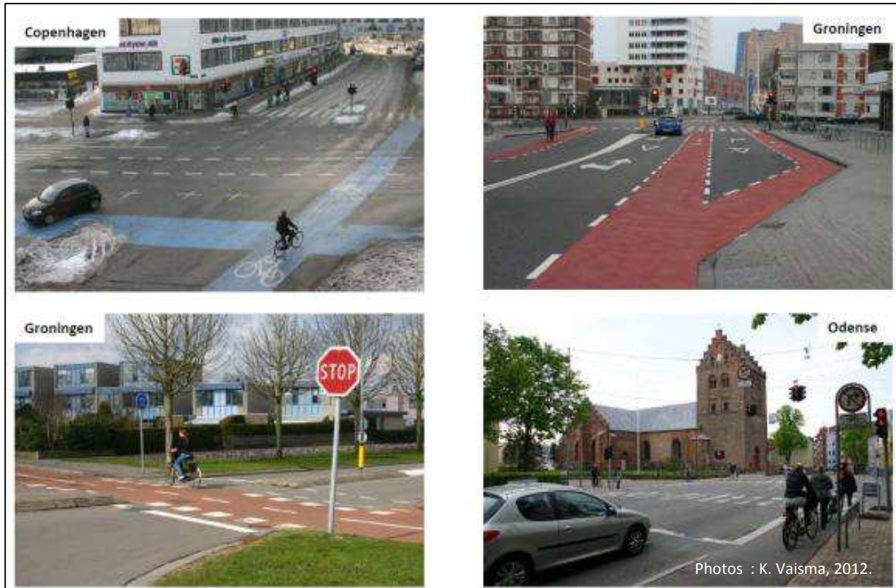
Figure 129 Exemples d'aménagement du corridor cyclable aux intersections (Vaisma, 2012)
