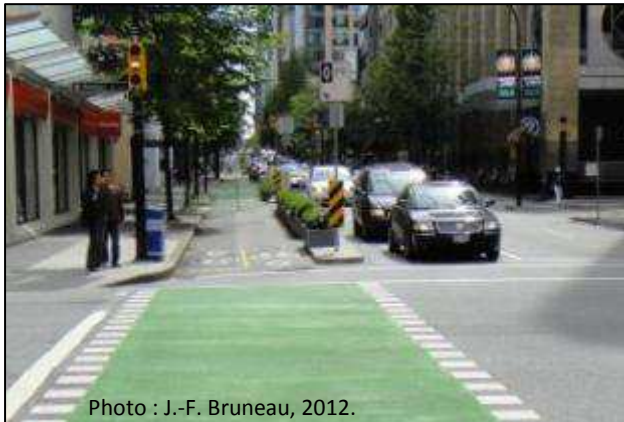
Figure 292 Piste cyclable séparée de la chaussée
