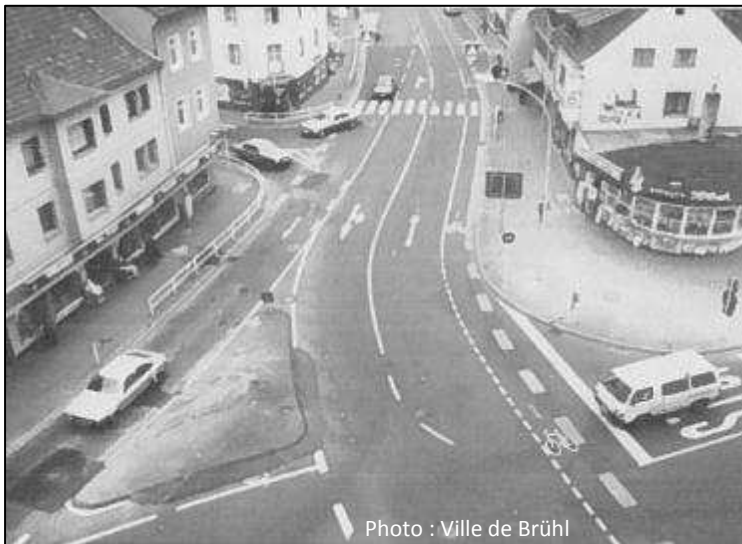
Figure 248 Stern Platz : giratoire remplacé par zone à priorité piétonne (Brühl, Allemagne)
