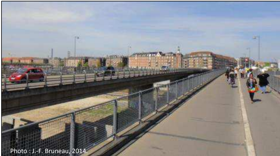
Figure 202 Ponts séparés pour véhicules et clientèles actives (Copenhague, Danemark)
