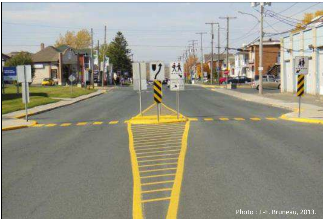
Figure 93 Avancée de trottoir et refuge central (Asbestos, Québec)
