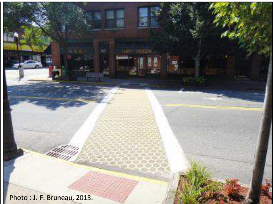
Figure 84 Passage texturé et coloré à l'intersection (Sherbrooke à gauche, North Conway à droite)
