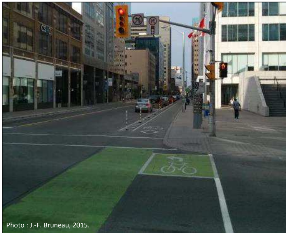
Figure 147 Sas implanté de l'autre côté de l'intersection (Ottawa, Ontario)
