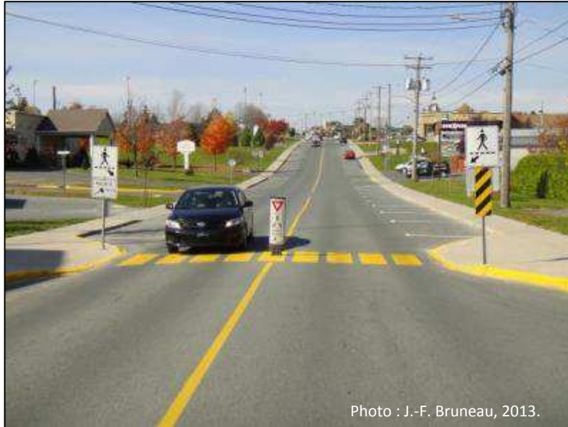
Figure 89 Avancée de trottoir et balise (Asbestos, Québec)
