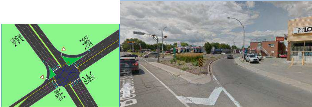
Figure 199 Îlot déviateur éliminé entre les boulevards St-Martin et Curé-Labelle (Laval)
