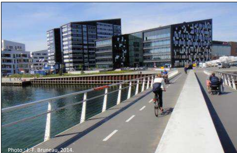
Figure 203 Le Bryggebro est uniquement pour cyclistes et piétons (Copenhague, Danemark)
