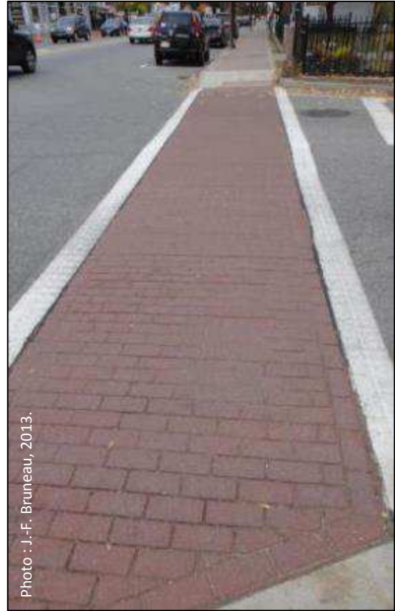
Figure 84 Passage texturé et coloré à l'intersection (Sherbrooke à gauche, North Conway à droite)
