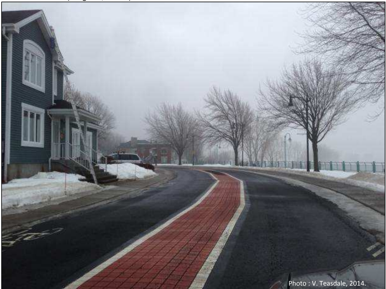
Figure 100 Refuge central composé de tuiles thermoplastiques (Varenes, Québec)
