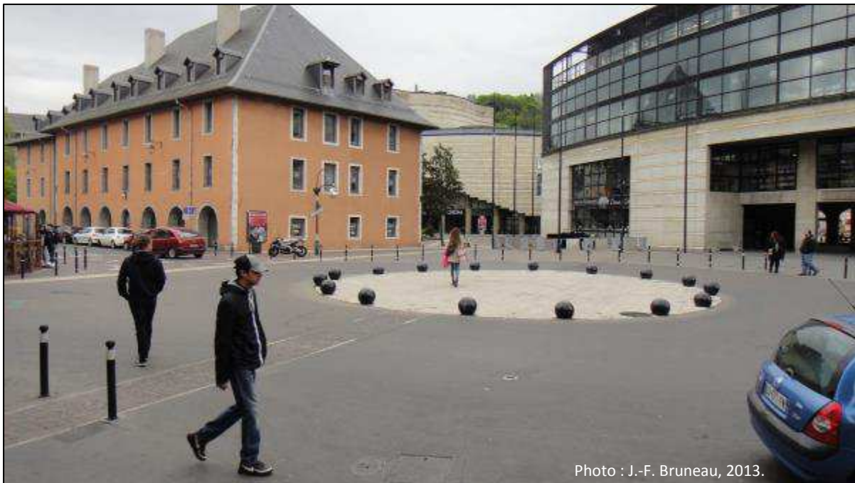
Figure 46 Les piétons peuvent traverser au centre du giratoire (Chambéry, France)
