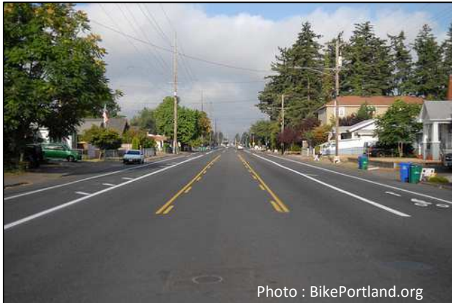
Figure 295 Voies cyclables unidirectionnelles
