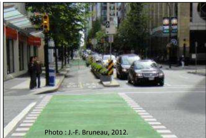
Figure 121 Voie cyclable bidirectionnelle protégée (Vancouver, C.-B.)
