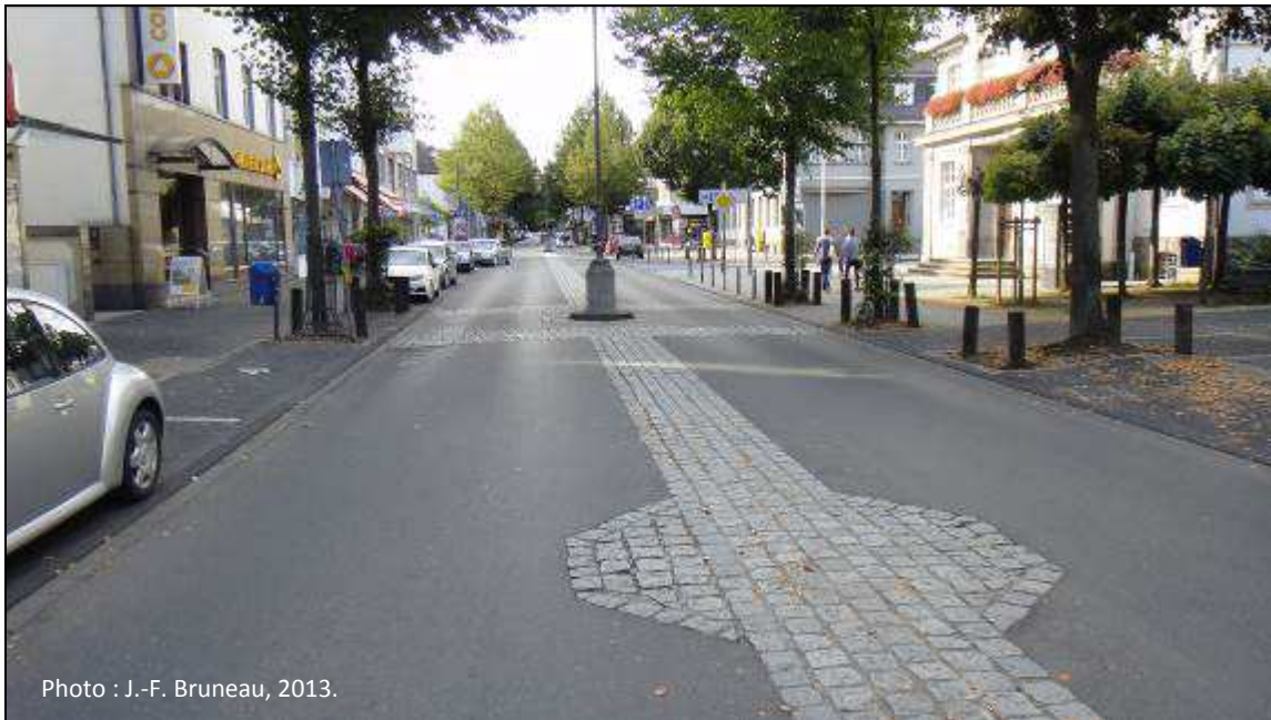
Figure 95 Élargissement octogonal du refuge central (Hennef, Allemagne)
