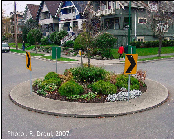
Figure 64 Le giratoire n’est pas franchissable (à gauche) et le mini-giratoire l’est (à droite)
