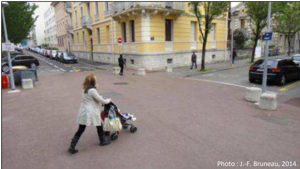
Figure 58 Intersection surélevée revêtue d'asphalte coloré (Chambéry, France)
