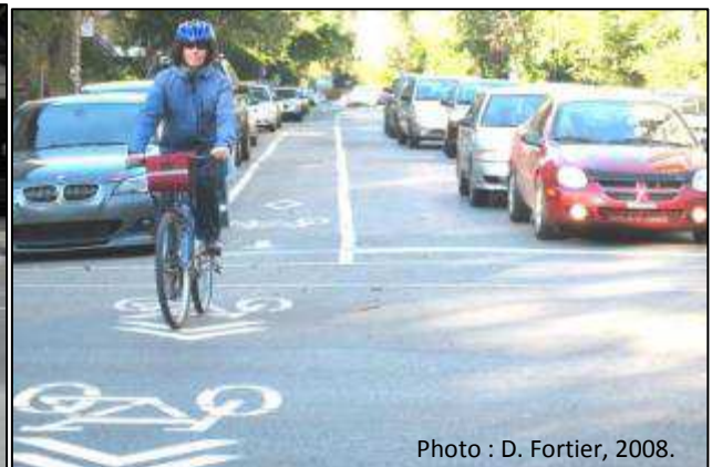
Figure 291 Bande cyclable sur la chaussée
