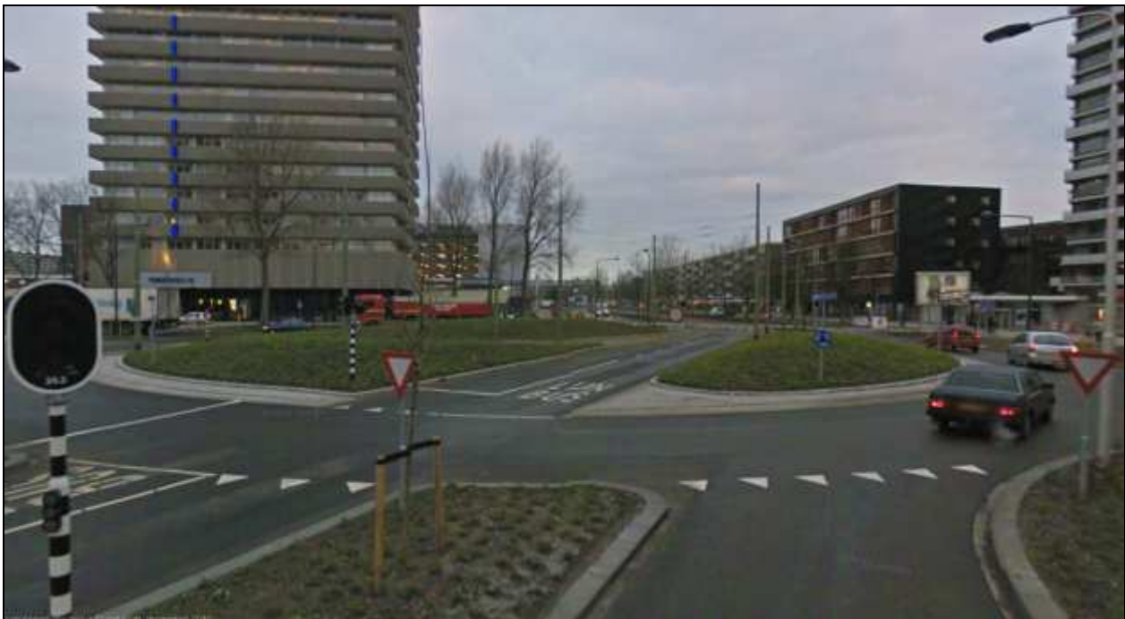
Figure 158 Situation après l'aménagement du giratoire de Delflandplein (Delft, Pays-Bas)
