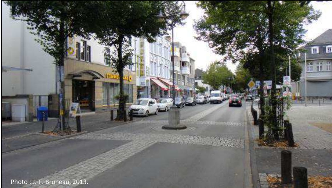
Figure 94 Refuge central avec un design qui évoque un passage piéton (Hennef, Allemagne)
