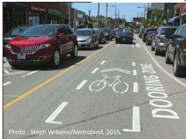
Figure 138 Marquage expérimental de l’emplacement idéal pour circuler à vélo (Ottawa, Ontario)
