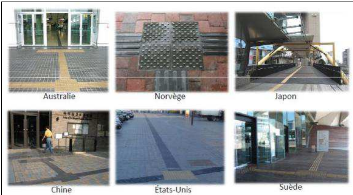
Figure 77 Tuiles de guidage utilisées dans le monde
