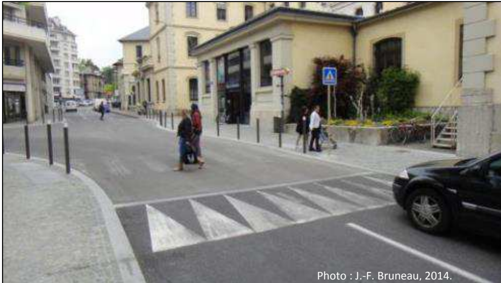
Figure 57 Intersection surélevée servant aussi de passage piéton (Chambéry, France)
