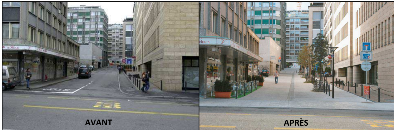
Figure 41 Rue des Marronniers (Genève, Suisse) avant et après l'aménagement en zone de rencontre
