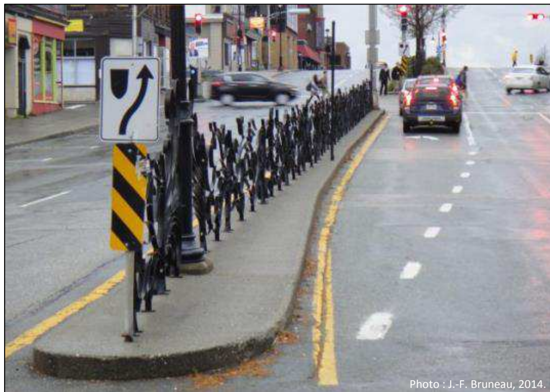
Figure 101 Clôture canalisant les piétons vers les intersections (Sherbrooke, Québec)
