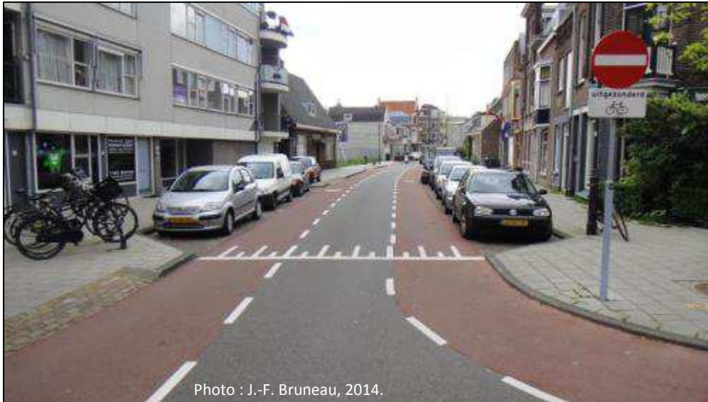
Figure 70 Largeur de voie réduite au minimum avec voies cyclables (Zandvoort, Pays-Bas)
