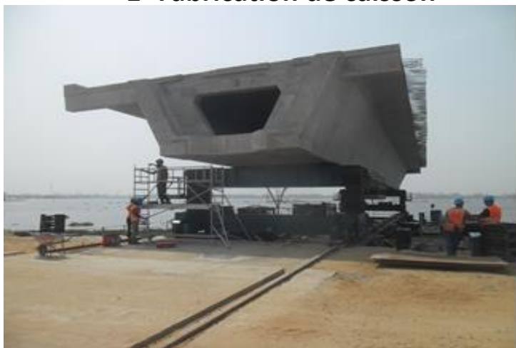
1- Fabrication de caisson
