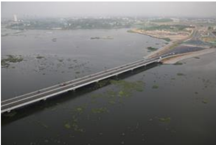
3- Pont HKB reliant et la partie Nord et la Partie Sud
