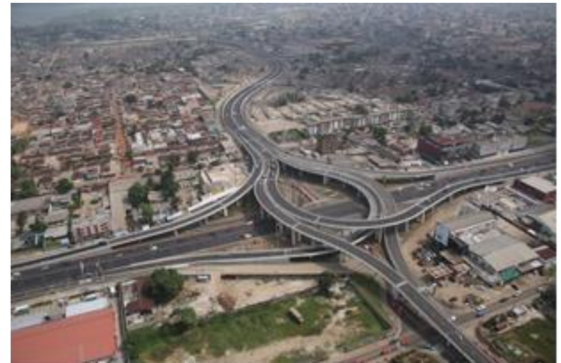
4- Projet terminé dans la partie Sud par un Echangeur
