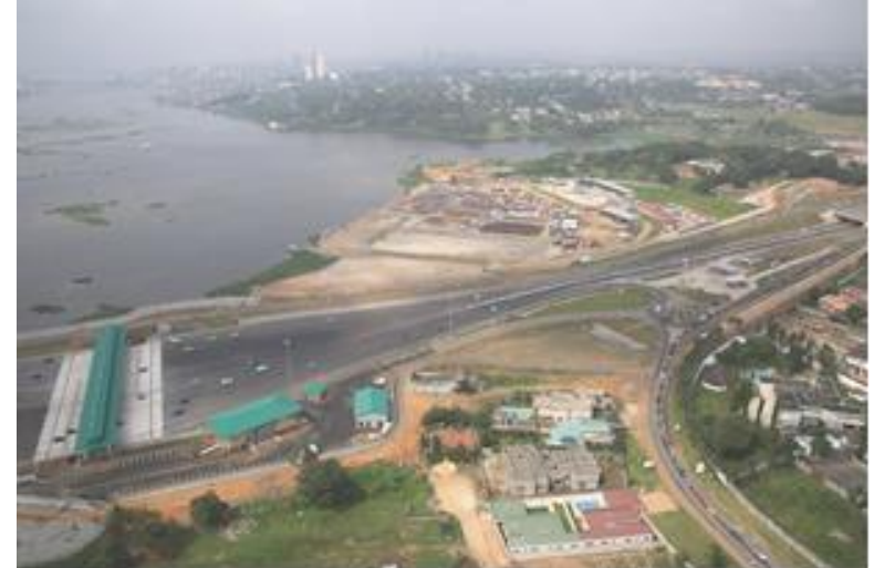
2 -Zone de Péage dans la partie Nord Cocody -Riviéra
