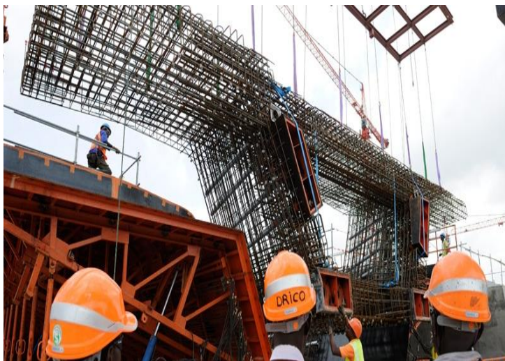
1- Fabrication de caisson
