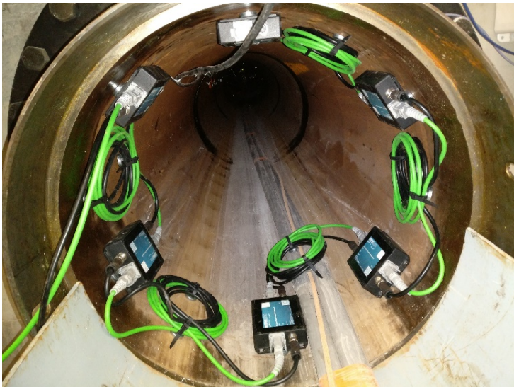
Instrumentation d'une alvéole sur le site de Bure
