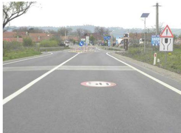
Préparer les conducteurs à ralentir à l'approche d'un lotissement urbain. Cet exemple comprend une chicane de niveau 1 dans la hiérarchie, laquelle limite la vitesse des véhicules en leur imposant un déplacement latéral.
