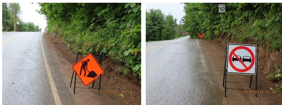
Fig. 18 et 19 - Panneau T-50-1 et P-140-1 direction sud
