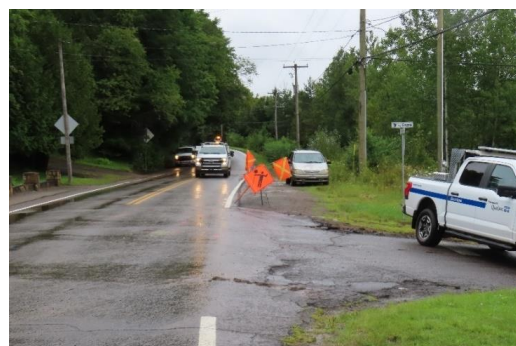
Fig. 16 - Panneau T-60 direction nord Source : CNESST
