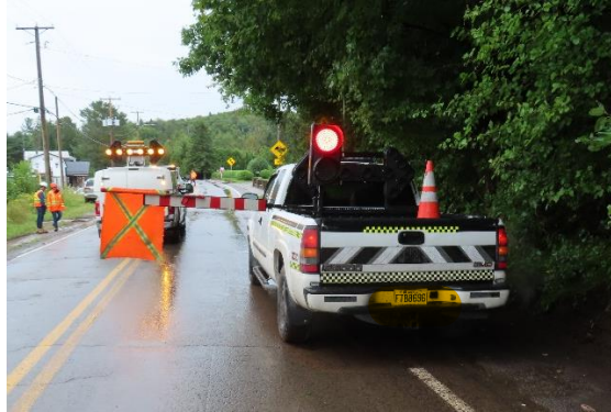
Fig. 21 – Barrière de contrôle de la circulation pour travaux Source : CNESST
