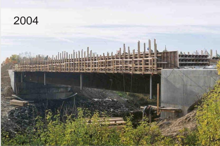
Type : Pont à poutres en acier avec travée unique (biais de 20°)
